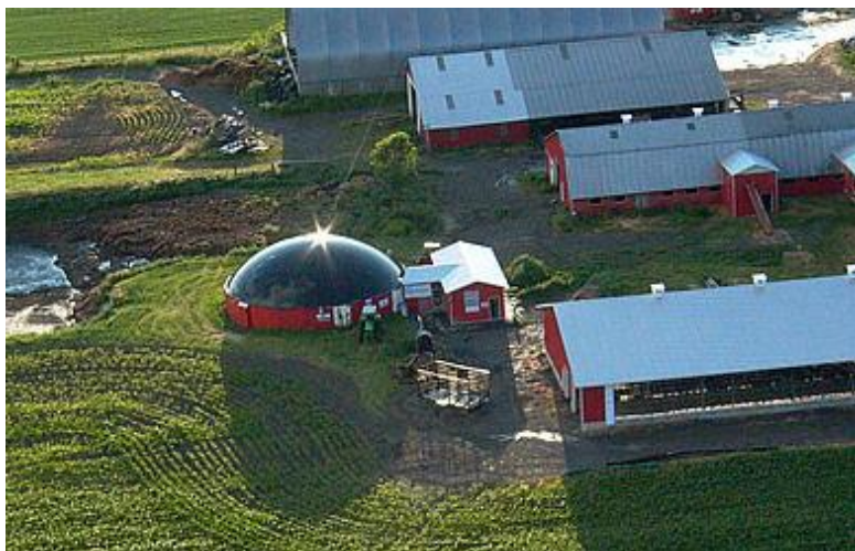
Fermentator cu producere de biogaz la nivel de ferma agricolă
