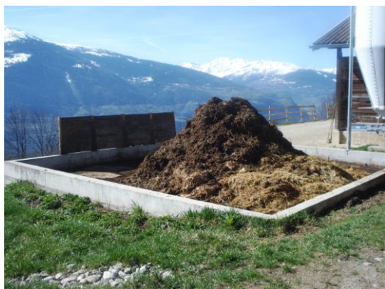
Platformă de stocare a gunoiului de grajd etanșeizată cu bazin acoperit pentru depozitarea dejecțiilor lichide
